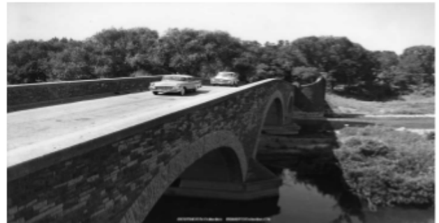
Pont en arc Old Mill- construit 1916. Rivière Humber River Valley, Toronto, Ontario.
