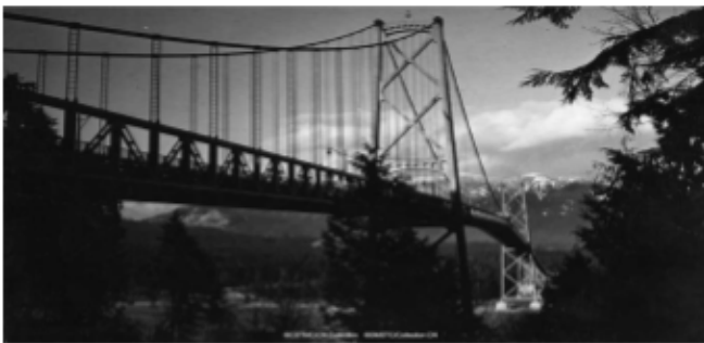
Pont suspendu Lion's Gate - construit 1938. Burrard Inlet, Vancouver, Colombie Britannique
